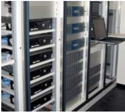
Die gesamte Steuerelektronik, Live- und Sendeserver sowie alle Computer sind in speziell klimatisierten Apparateräumen untergebracht
