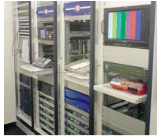
Die gesamte Steuerelektronik, Live- und Sendeserver sowie alle Computer sind in speziell klimatisierten Apparateräumen untergebracht
